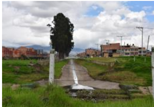
Canal Calle 38 Sur
